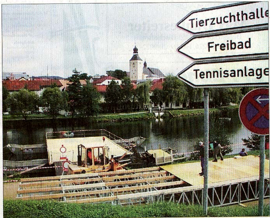
Da geht's lang in Richtung Flussbühne. Bauhof-Mitarbeiter haben gestern begonnen, an der Abfahrt zur Tierzucht-halle die Tribüne für die Zuschauer aufzubauen. (Foto: Frisch)
